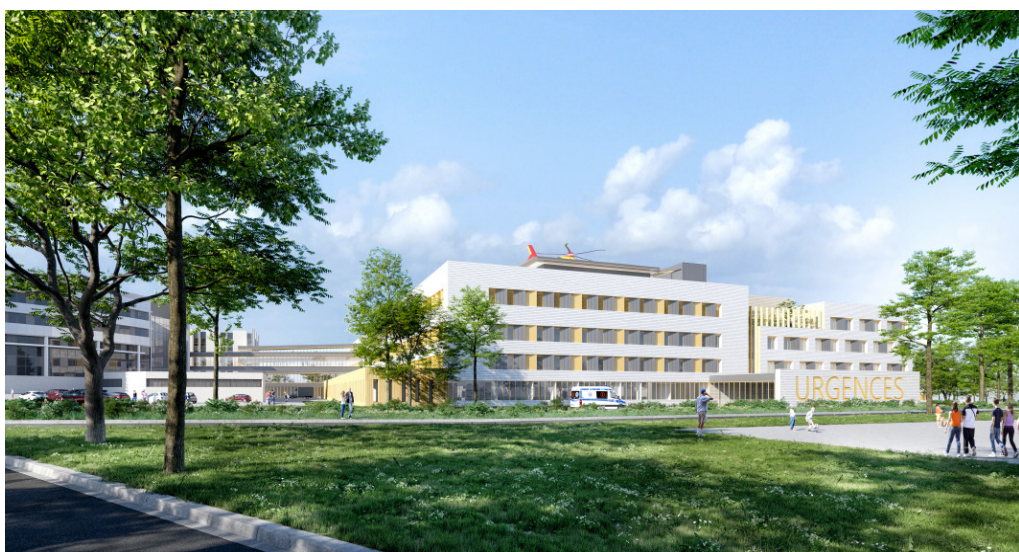
Un accès aux urgences lisible.
